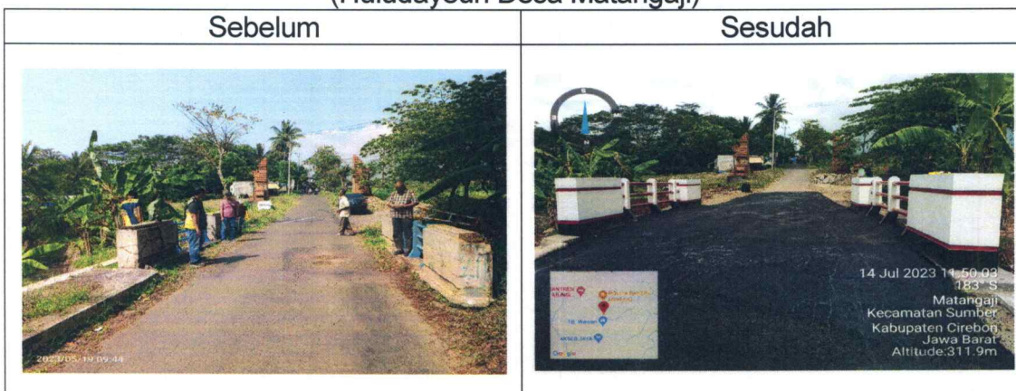
Foto III.6 Rehabilitasi Jembatan pada Ruas Jalan Sidawangi - Matangaji (Huludayeuh Desa Matangaji)
