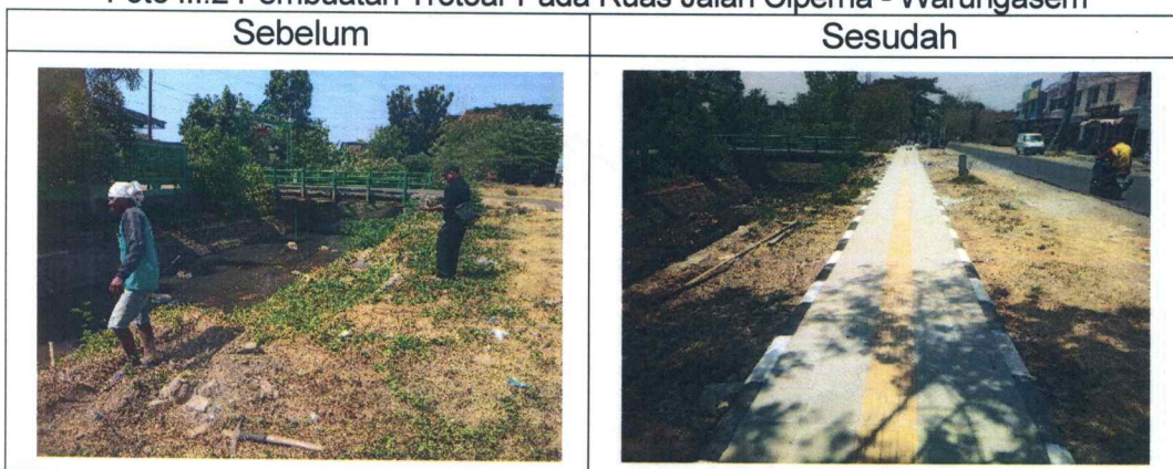
Foto III.2 Pembuatan Trotoar Pada Ruas Jalan Ciperna - Warungasem
