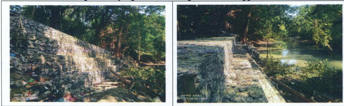
Foto III.9 Normalisasi Kali Soka Kec. Plumbon
