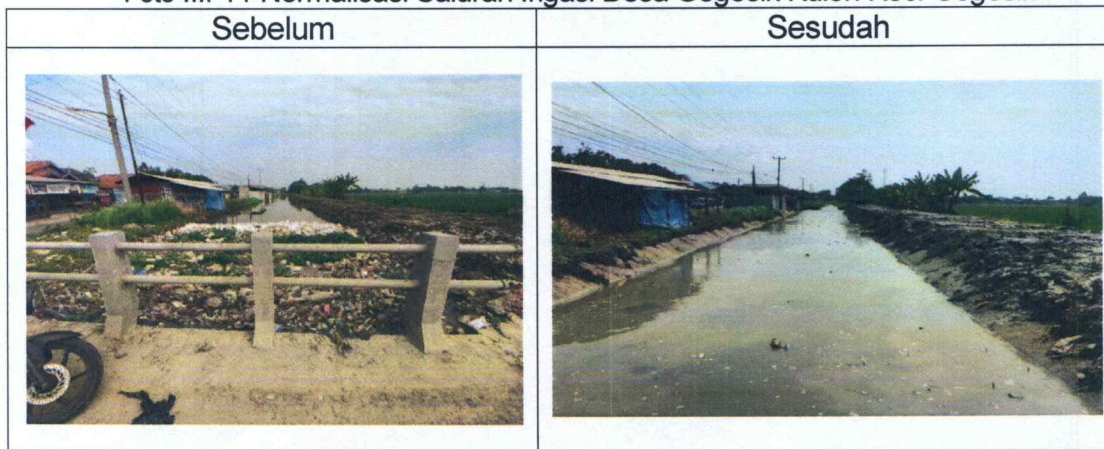
Foto III. 11 Normalisasi Saluran Irigasi Desa Gegesik Kulon Kec. Gegesik
