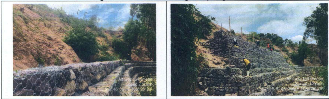
Foto III.8 Pemasangan Bronjong Kali Jamblang Desa Pesanggrahan Kec. Plumbon
