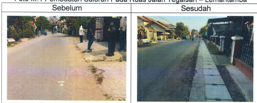
Foto III.1 Pembuatan Saluran Pada Ruas Jalan Tegalsari – Lemahtamba
