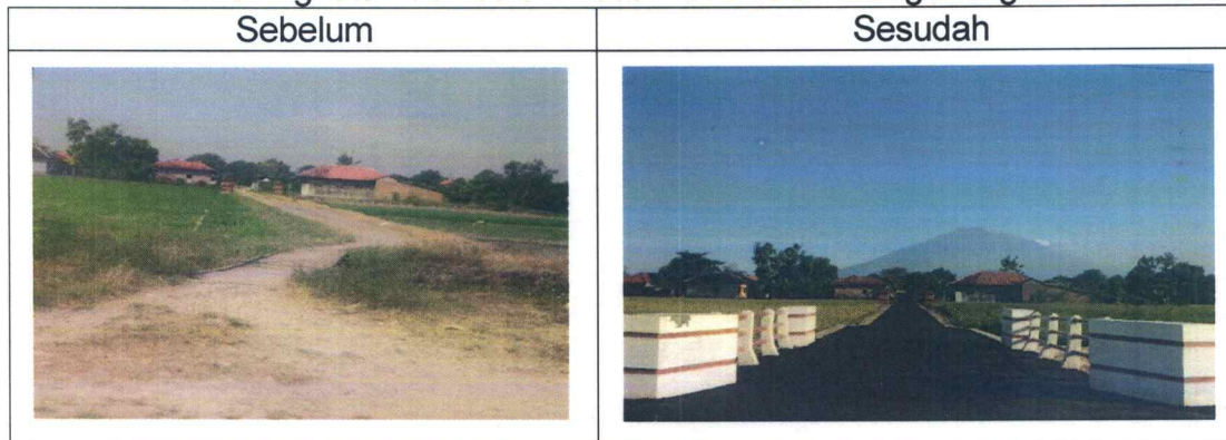
Foto III.5 Peningkatan Jembatan Pada Ruas Jalan Canguang - Jemaras
