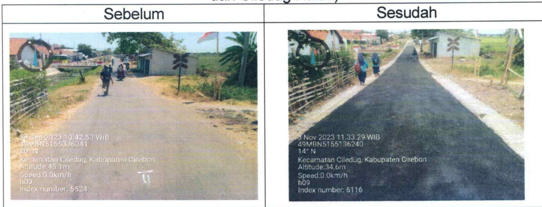
Foto III.4 Pemeliharaan Periodik Jalan Ciledug Lor - Bantarsari (Ciledug Tengah dan Ciledug Kulon)
